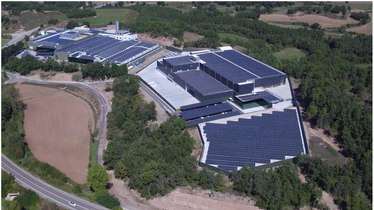
Centro productivo en Olost, donde se lleva a cabo el proceso de uso circular del agua
