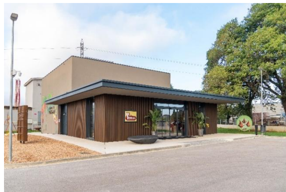
Instalaciones Shop & Show
